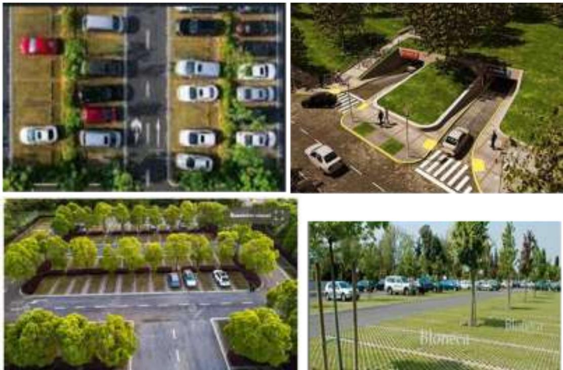
Figura 27. Tipologías indicativas de Estacionamientos sustentables con incorporación de vegetación y suelo absorbente, materiales y asfalto absorbentes.
